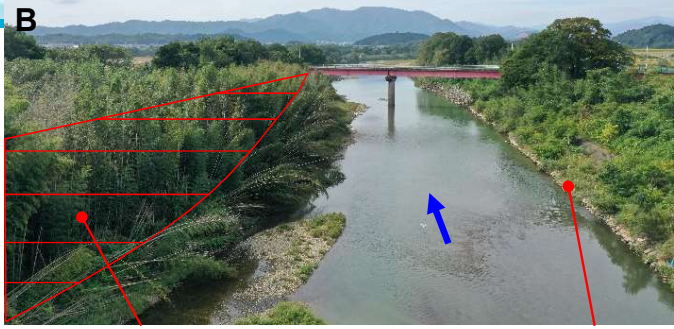
掘削範囲(タイプ③)+水制 既設護岸
