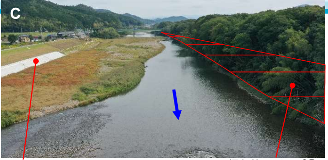
既設護岸 掘削範囲(タイプ①)
