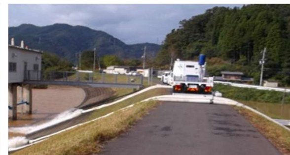
排水状況(池部樋門、H30.7.7)
