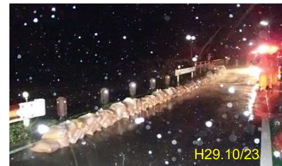
積み土のう工完了
