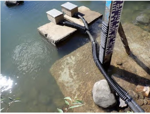
センサー保護管補修作業後
