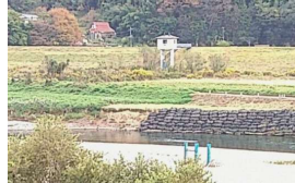
低水護岸崩落箇所の補修
