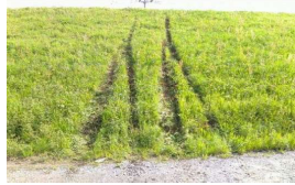
車両による踏み荒らしの状況
