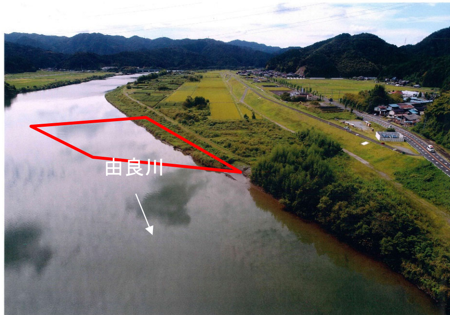
河道掘削箇所
