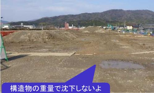
構造物の重量で沈下しないよう、地盤改良が完了しました。
