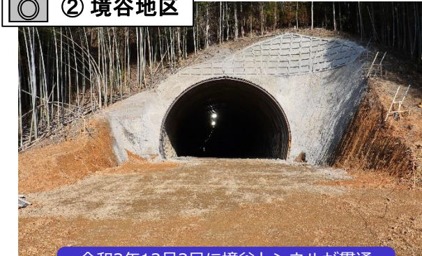
令和3年12月2日に境谷トンネルが貫通し、現在は覆工工事を行っています。
