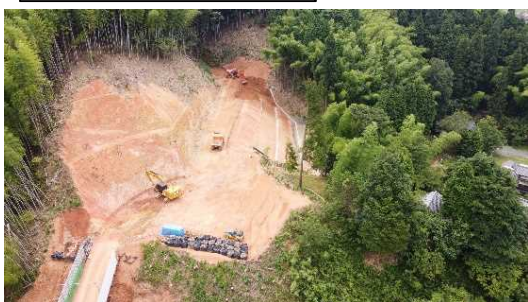
仮橋からトンネル坑口に向けて山を切り始めました。
