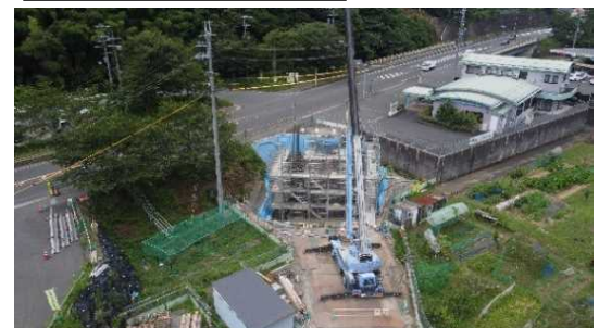
橋台を工事しています。
