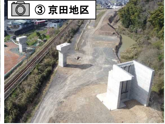
橋台、橋脚ができあがりました。
