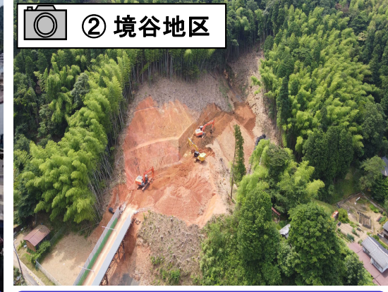
仮橋からトンネル坑口に向けて山を切り始めました。
