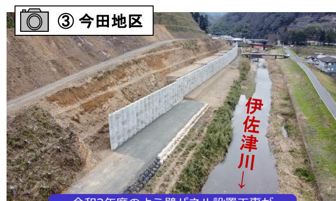
令和3年度のよう壁パネル設置工事が完了しました。
