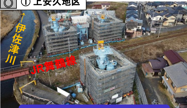
高架橋下部工事のケーソン基礎工を実施
