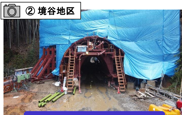
トンネルの覆工工事を行っています。
