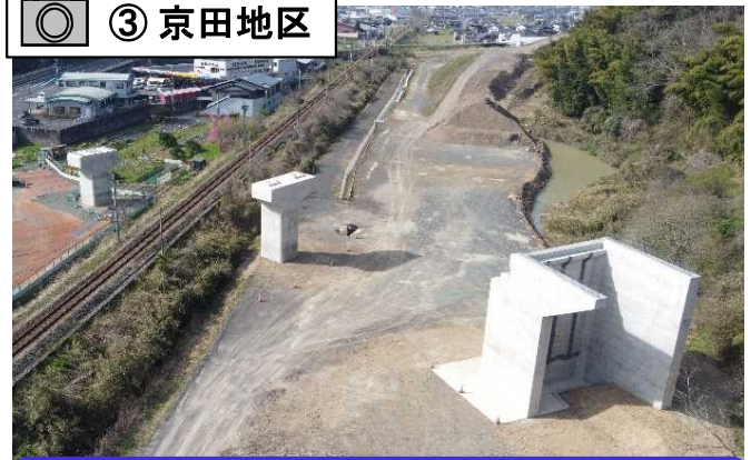
橋台、橋脚ができあがりました。
