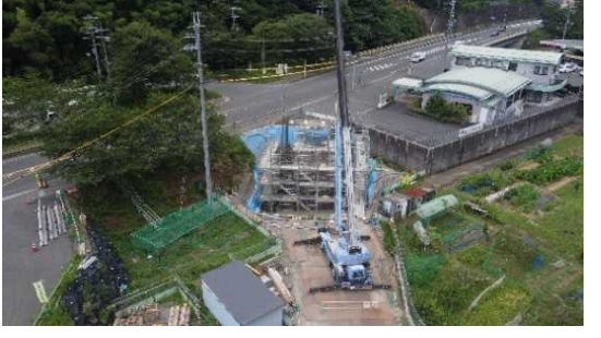
橋台を工事しています。
