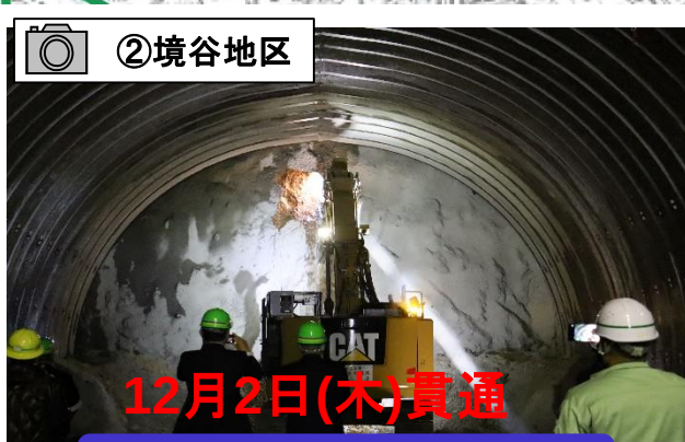
境谷トンネルが貫通しました。
