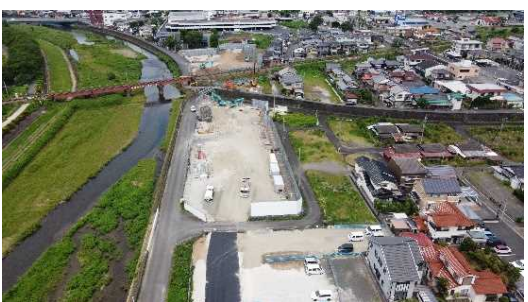
高架橋下部工事の準備工を実施
