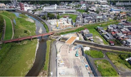
高架橋下部工事の準備工を実施
