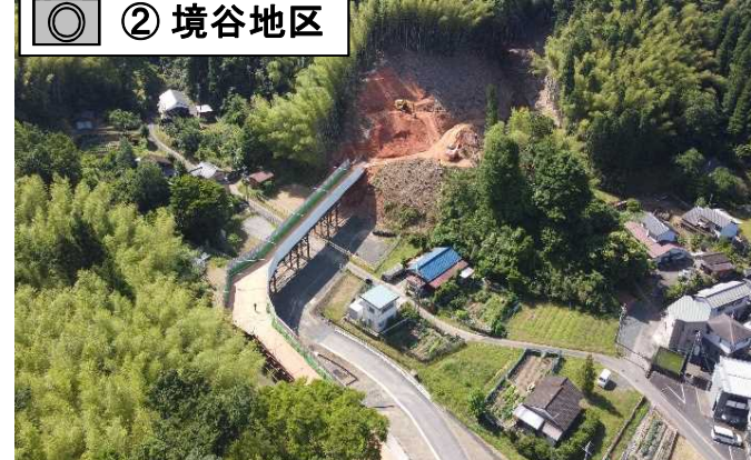
仮橋からトンネル坑口に向けて山を切り始めました。
