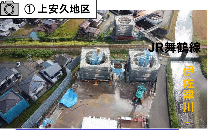
高架橋下部工事のケーソン基礎工を実施 トンネル掘削工事を行っています。 橋台を工事しています。
