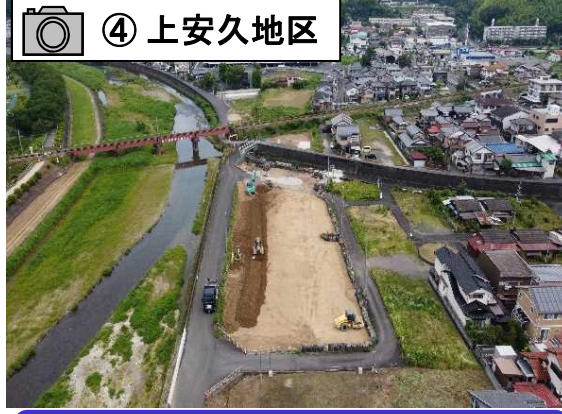
高架橋下部工事の準備工を実施
