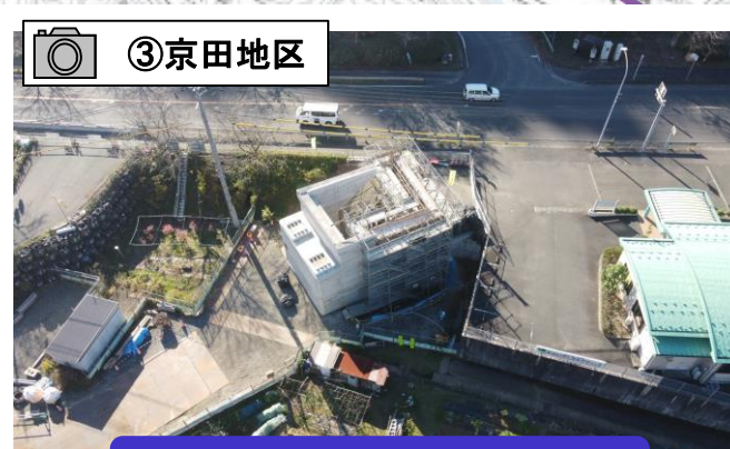
橋台を工事しています。
