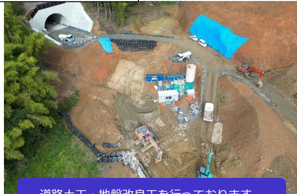
道路土工・地盤改良工を行っております。
