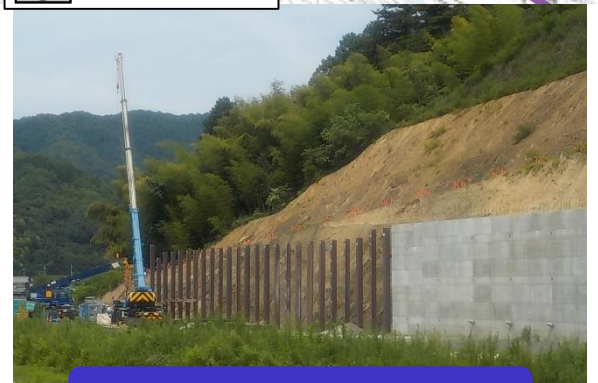
擁壁の設置を進めております。
