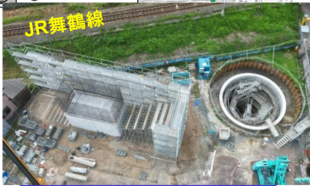
左：高架橋下部の型枠工事を実施 右：ケーソン基礎工を実施
