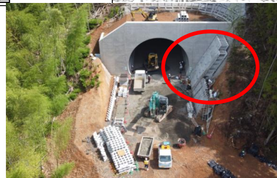
トンネル終点側で、ブロック積み擁壁工を実施
