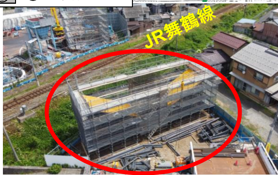
高架橋下部の型枠工事を実施
