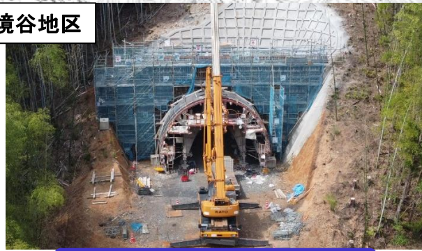
こうもん トンネル終点側の坑門(※)工を実施
