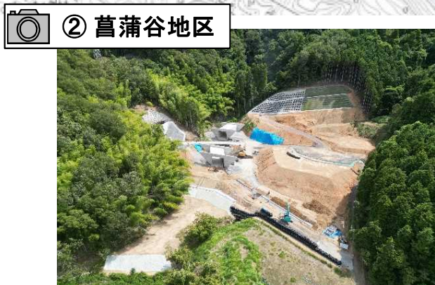
盛土及び排水構造物の施工を行っています。
