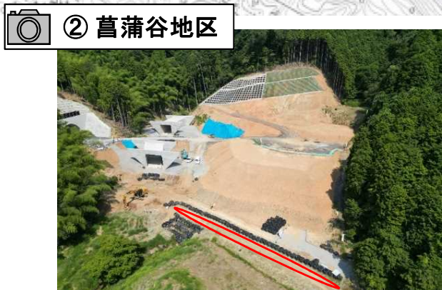
切土面の法枠工が完成し、盛土の法尻水路に着手します。
