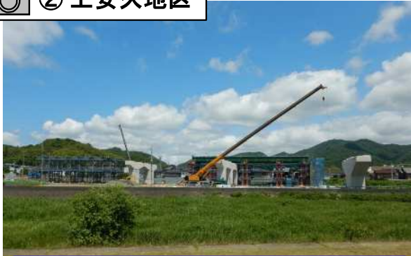
上安久高架橋(仮称)の上部工の架設ヤードの施工を行っています。
