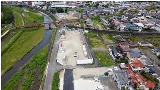
高架橋下部工事の準備工を実施
