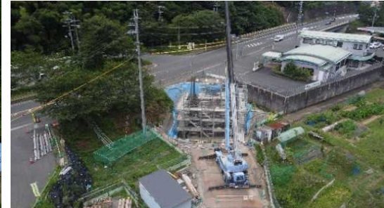
橋台を工事しています。
