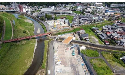
高架橋下部工事の準備工を実施
