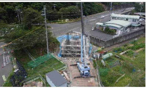
橋台を工事しています。
