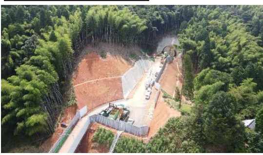
トンネル坑口付近が完成しました。
