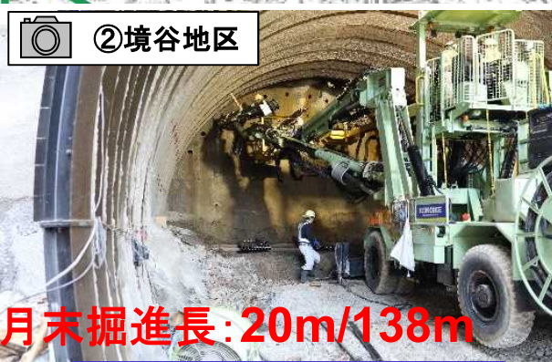
トンネル掘削工事を行っています。
