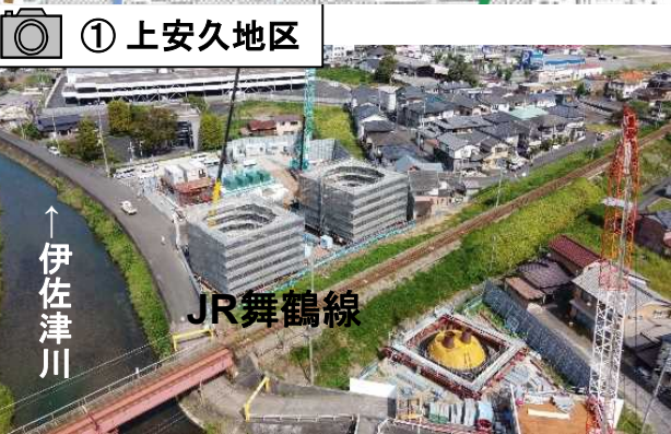
高架橋下部工事のケーソン基礎工を実施
