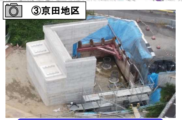
橋台を工事しています。
