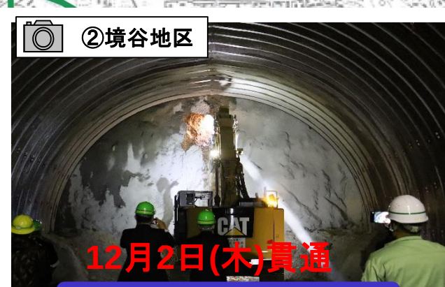
境谷トンネルが貫通しました。
