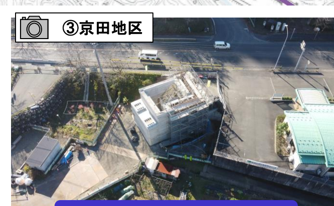
橋台を工事しています。
