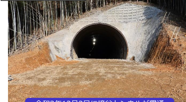
令和3年12月2日に境谷トンネルが貫通し、現在は覆工工事を行っています。
