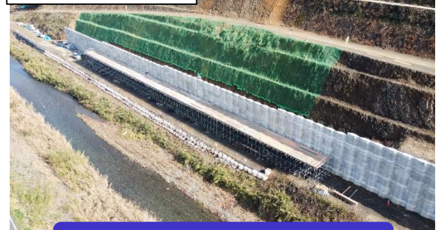
よう壁パネルの設置を進めています。
