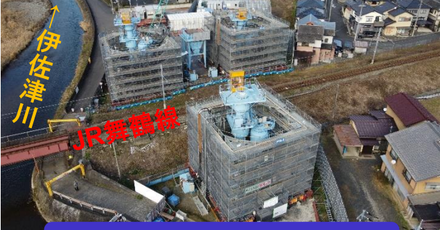
高架橋下部工事のケーソン基礎工を実施
