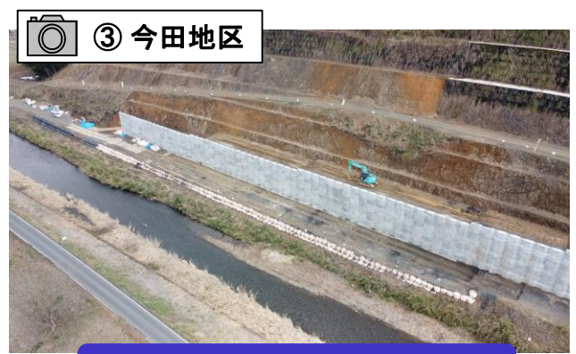
よう壁パネルの設置を進めています。
