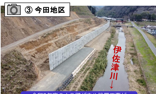
令和3年度のように壁パネル設置工事が完了しました。
