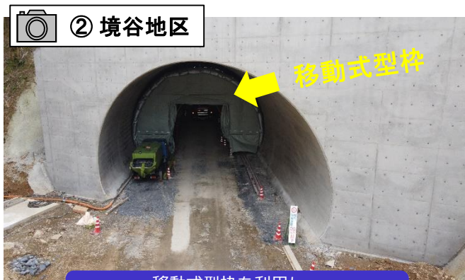
移動式型枠を利用し、覆工工事を行っています。
