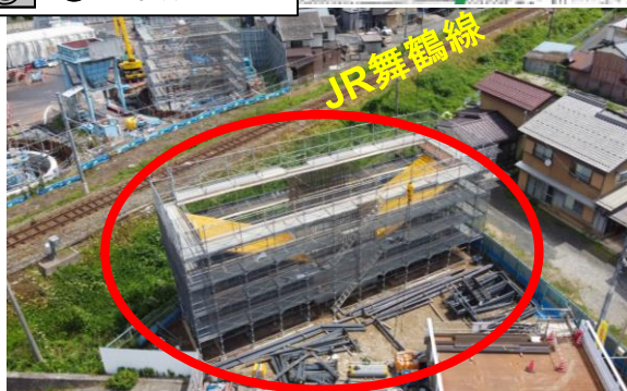
高架橋下部の型枠工事を実施
