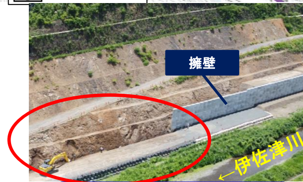
擁壁設置のために、掘削を行っており ます
