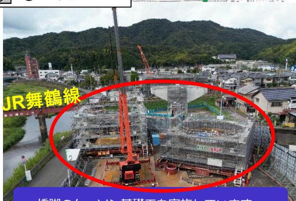
橋脚のケーソン基礎工を実施しています。
