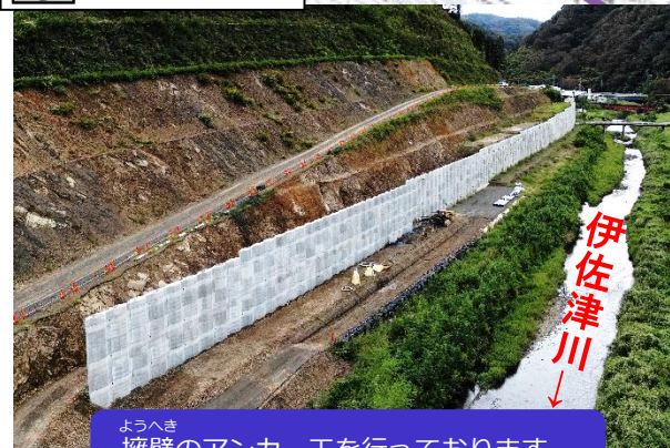
ようへき 擁壁のアンカー工を行っております。
