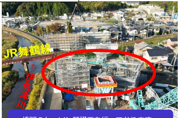
橋脚のケーソン基礎工を行っております。
