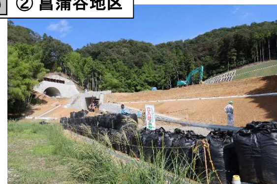
土を盛り、ブロックを積んで道を造っています。また、排水するための構造物を造っています。
