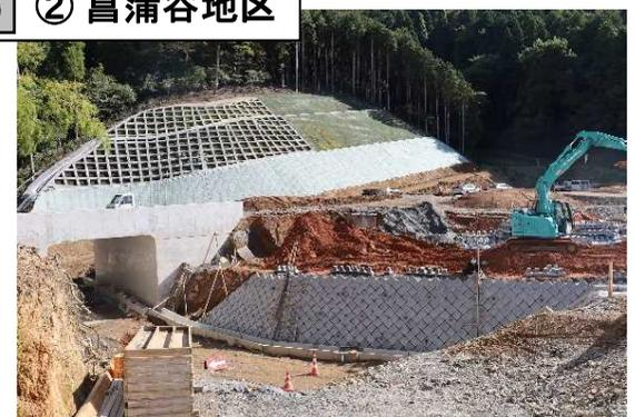
斜面の保護は完了し、引き続き土を盛り、ブロックを積んで道を作っています。
