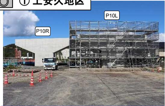
上安久高架橋(仮称)のP10R橋脚が完成。P10L橋脚はコンクリートの打ち込みが完了し、今後は足場と支保を撤去する予定です。
