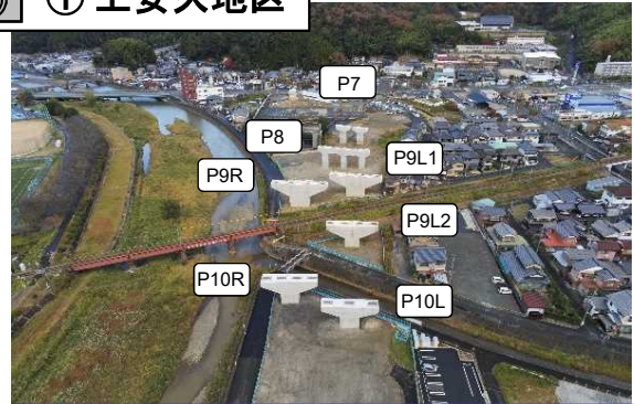
上安久高架橋(仮称)の下部工(P7～P10)が完了しました。
