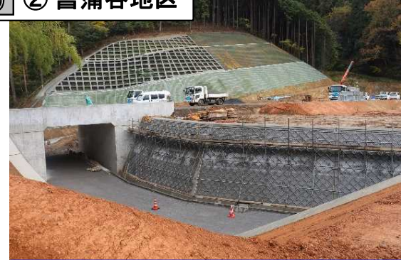
地面に碎石を敷き均し、ブロックを積み、市道の付替を行っています。
