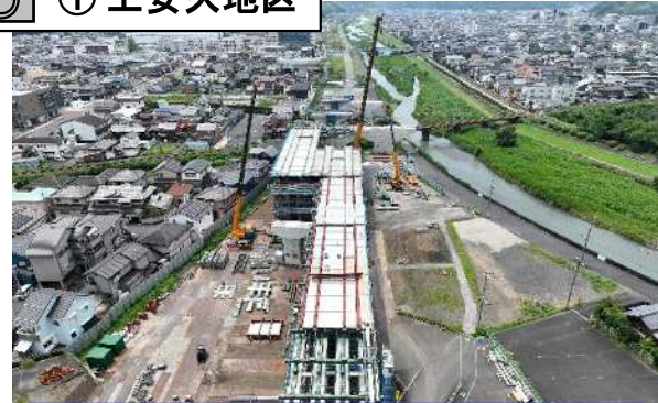
上安久高架橋(仮称)の上部工の架設ヤードの施工を行っています。
