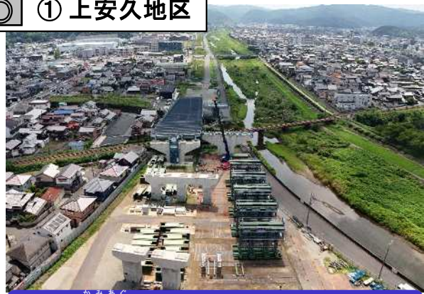
上安久高架橋(仮称)の上部工事の施工を行っています。
