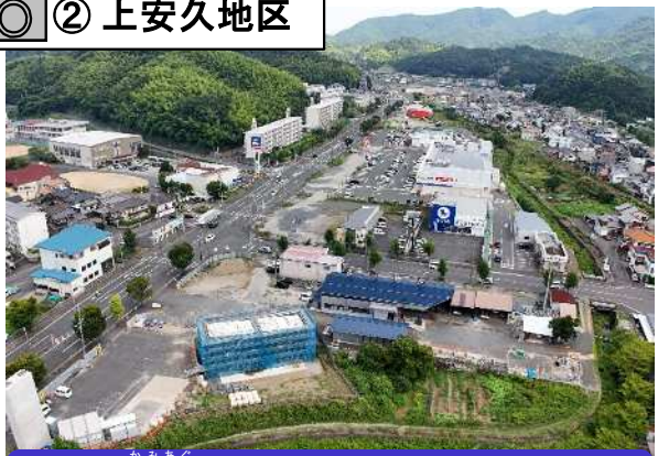
上安久高架橋(仮称)の下部工事の施工を行っています。
