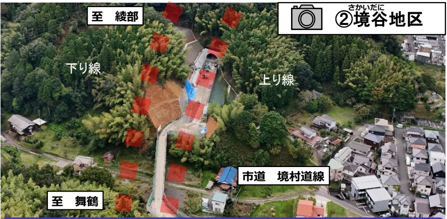
切土工事の施工を行っています。
