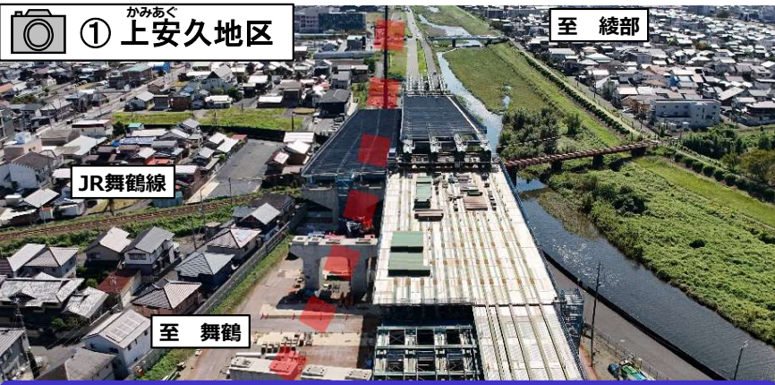
上安久高架橋(仮称)の上部工事の 施工を行っています。
