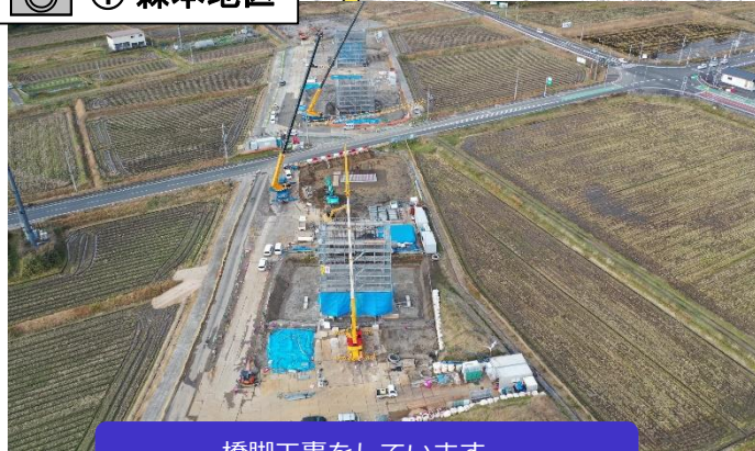
橋脚工事をしています。
