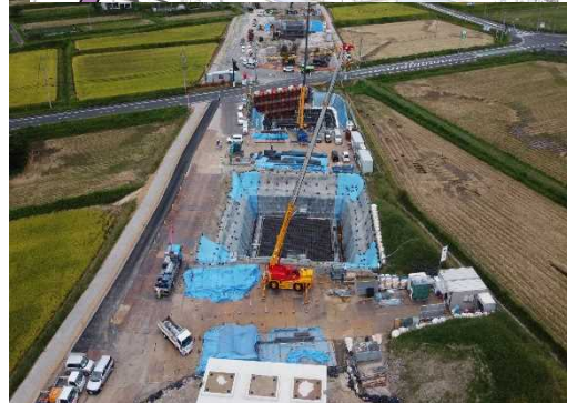
橋脚工事をしています。
