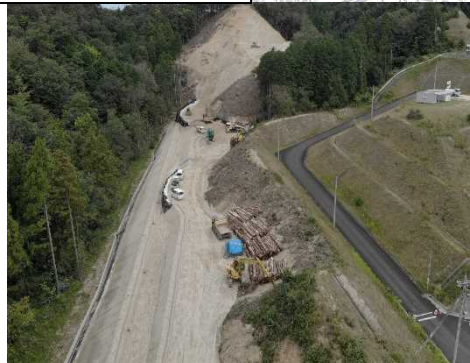
伐採が完了し、切土を行っています。
