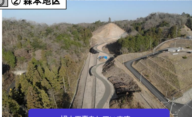
切土工事をしています。
