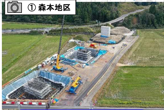
橋脚工事をしています。
