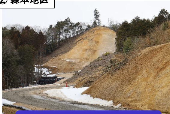
切土工事をしています。
