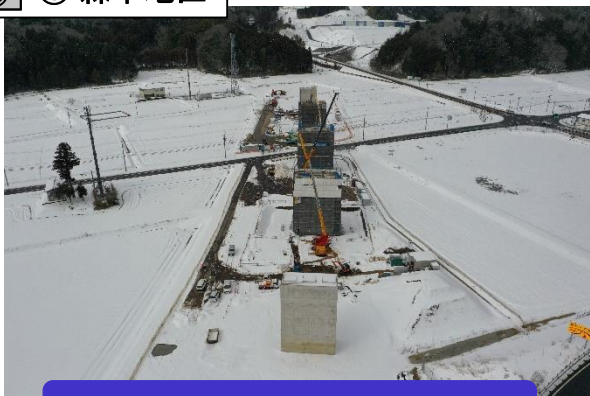
橋脚工事をしています。
