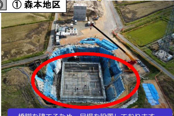
橋脚を建てるため、足場を設置しております。
