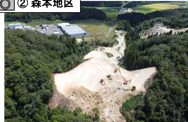
幅員 3 mの工事用道路をつくるため、引き続き山を掘削して土砂を搬出しています。
