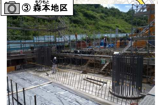
第一高架橋(仮称)の下部工の施工を行っています。
