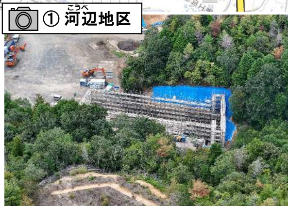
函渠を施工するため型枠の施工を行っています。
