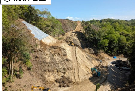
第2高架橋 (A2橋台) へ続く工事用道路を施工しています。
