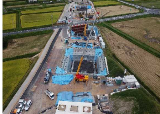
橋脚工事をしています。
