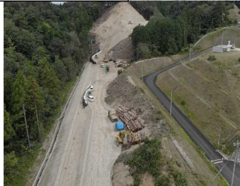
伐採が完了し、切土を行っています。
