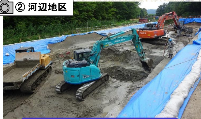
かんきよ 函渠工事のため、地盤改良を行っています。
