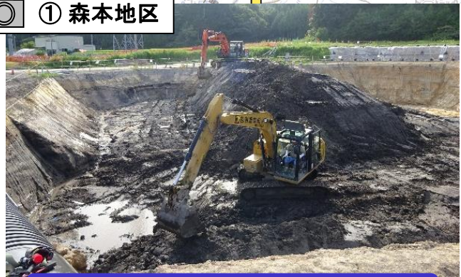
橋脚の基礎をつくるための準備を行っています。
