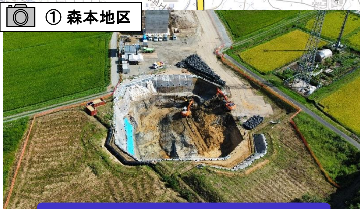
橋脚の基礎をつくるための準備を行っています。
