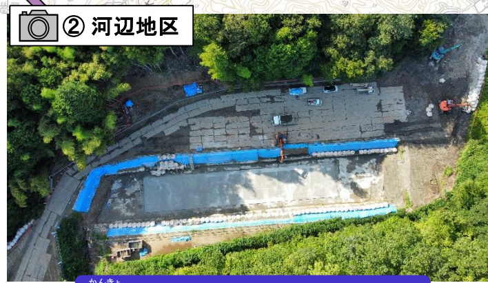
かんきよ 函渠工事のため、地盤改良を行っています。
