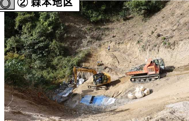
工事用道路を造るため、谷筋の盛土に着手しました。
