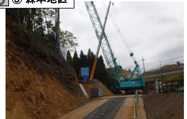
府道高架橋A1橋台を施工するために、矢板を打っています。
