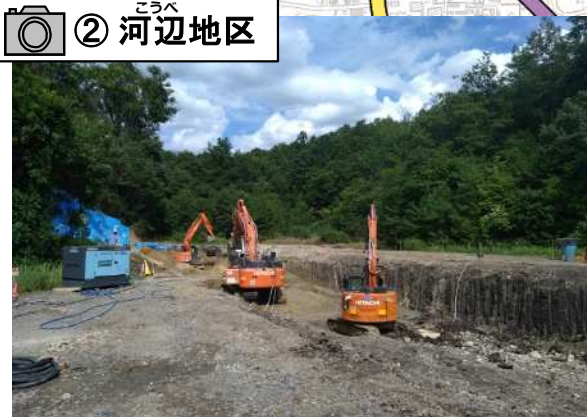
函渠を施工するため、地盤改良を行っています。
