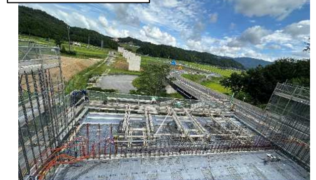
第一高架橋(仮称)の下部工の施工を行っています。
