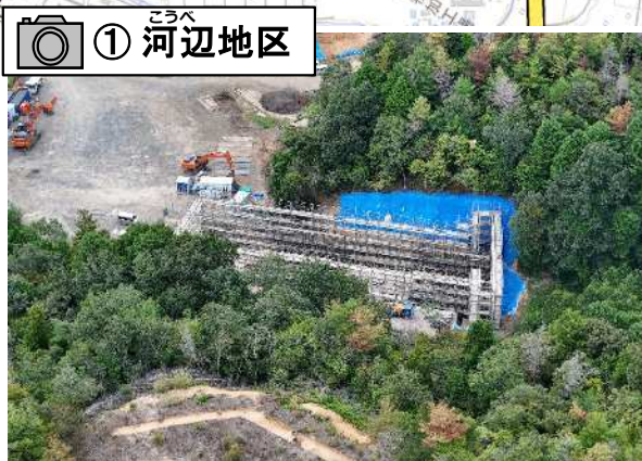
① 河辺地区 函渠を施工するため型枠の施工を行っています。
