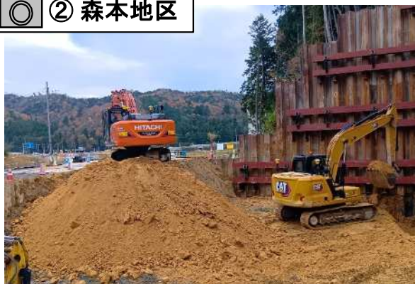
府道高架橋(仮称)の下部工の施工を行っています。
