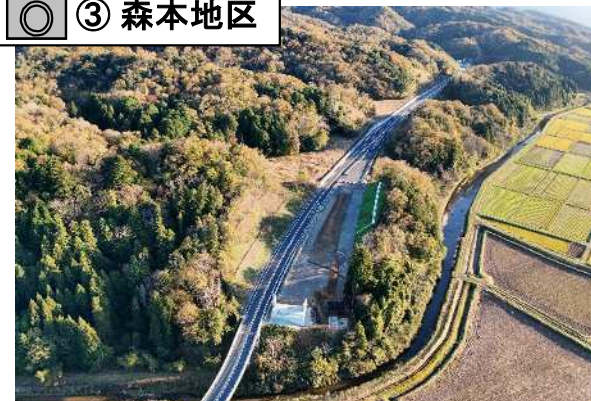
第一高架橋(仮称)の下部工(A1橋台)が完成しました。
