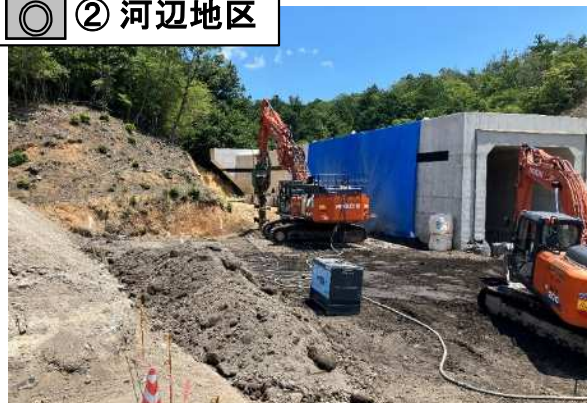
こうべ 河辺地区の地盤改良を行っています。
