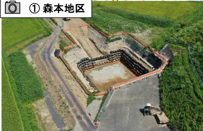
橋脚の基礎をつくるための準備をしています
