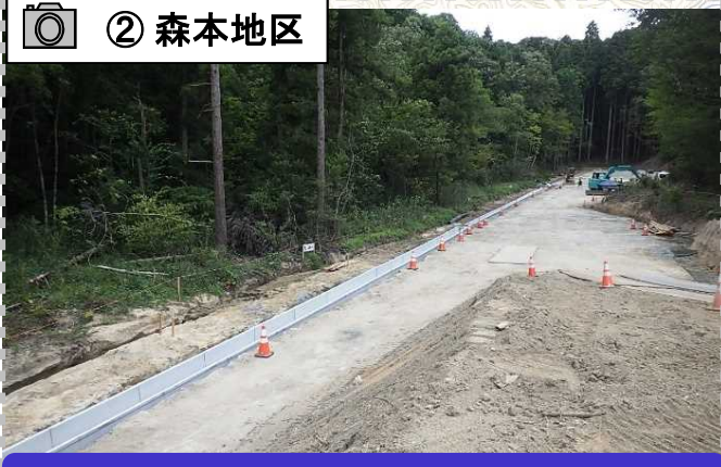
側溝を設置しています
