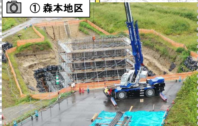
橋脚を作るための足場を設置しています
