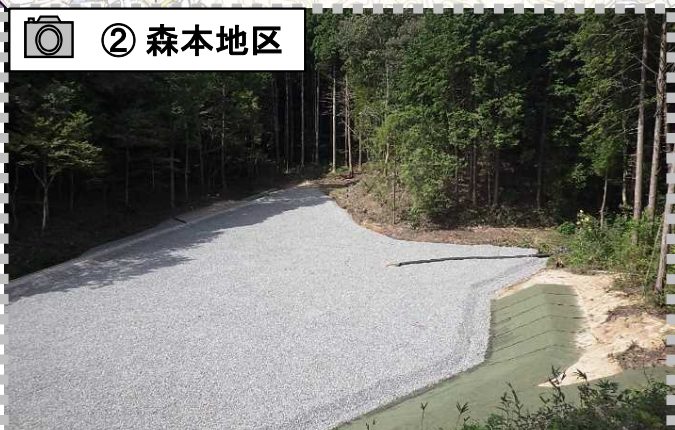
砂利を敷き詰めて排水層を施工しました。
