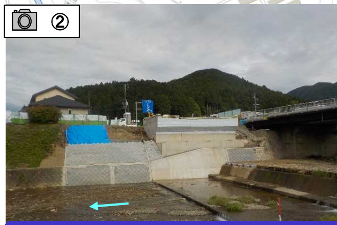
河川内の作業が完了し工事用道路を撤去しました
