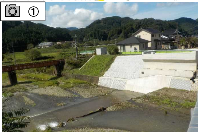
橋台と護岸が完成しました。
