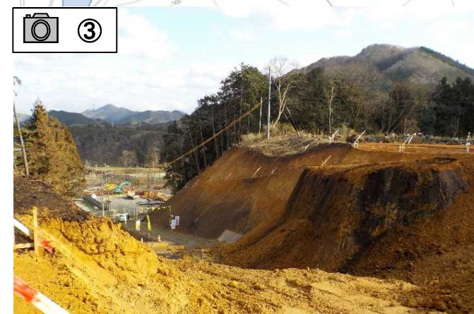
掘削作業中です。
