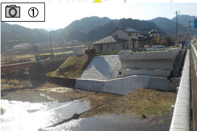
橋台と護岸が完成しました。
