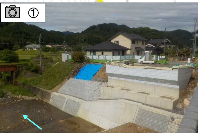
橋台と護岸をつくっています
