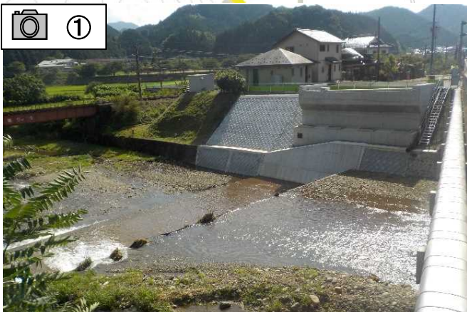
橋台と護岸が完成しました。
