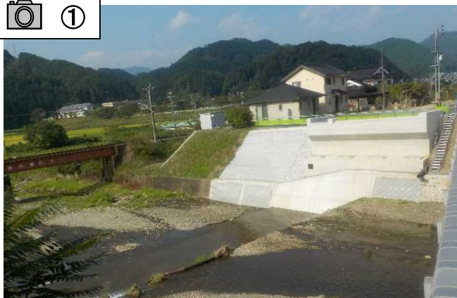
橋台と護岸が完成しました。
