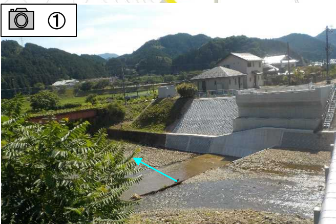
橋台と護岸が完成しました。
