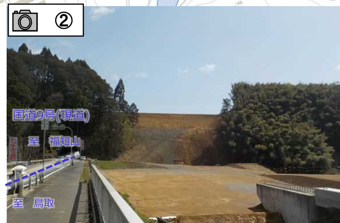
令和4年度の土工事が完成しました。
