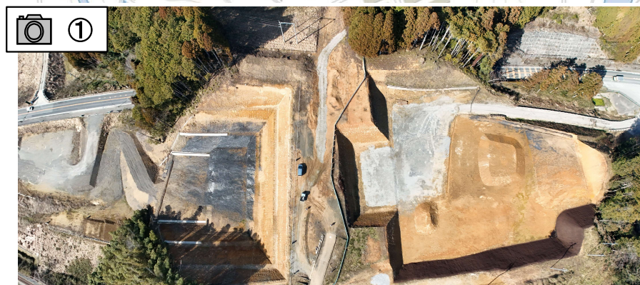
令和7年度の井田地区の切土工事が完了しました。
