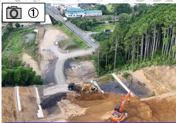
いだ 井田地区の切土工事をしています。
