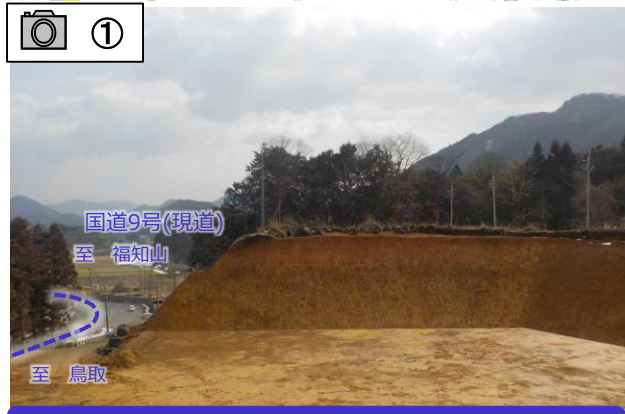
道路を作るために山を削っています。
