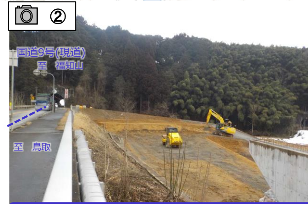
道路を作るために山を削った土を入れています。
