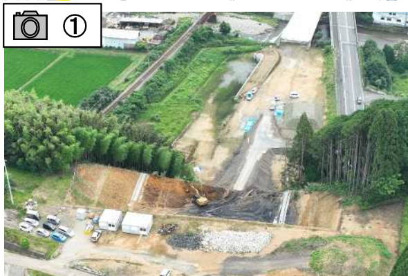
① いだ 井田地区の切土工事を行っています。
