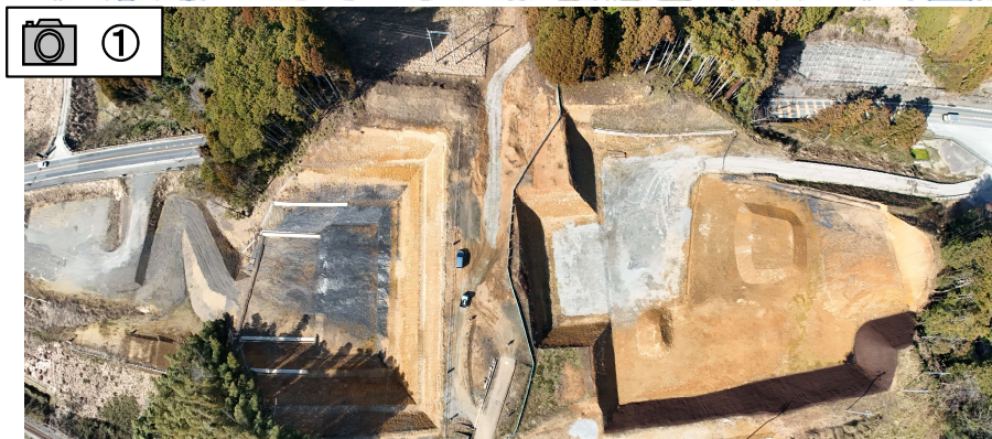
いだ 令和7年度の井田地区の切土工事が完了しました。
