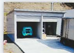
防災資機材倉庫(R2整備:みさきち)
