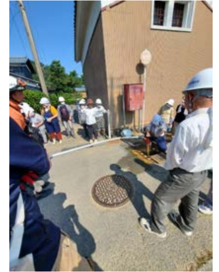
地下式消火栓操作
